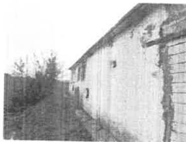
statie de pompare rasova (14)
