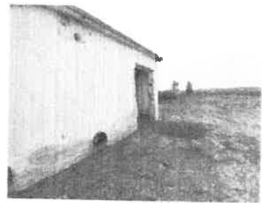
statie de pompare rasova (3)
