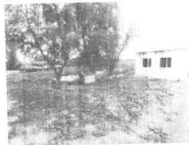
statie de pompare rasova (18)
