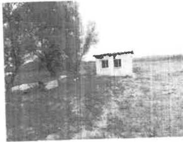
statie de pompare rasova (17)
