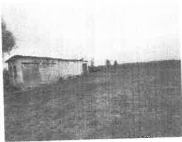
statie de pompare rasova (16)
