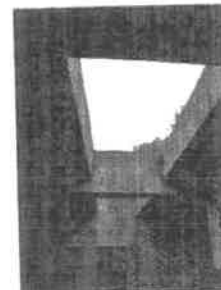
statie de pompare rasova (24)
