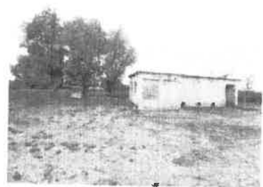
statie de pompare rasova (15)
